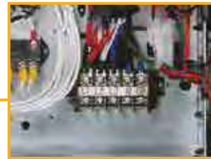
Dış ünite güç besleme terminal bloğu
